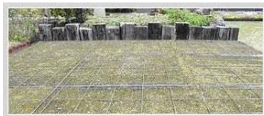
b. 屋頂的苔蘚類綠化(施工後)
